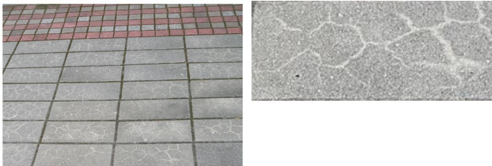
圖11 地上龜裂的地磚裂痕圖案
